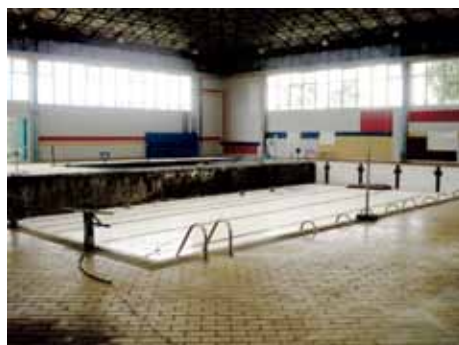
Figura 1 – Vista geral da piscina
