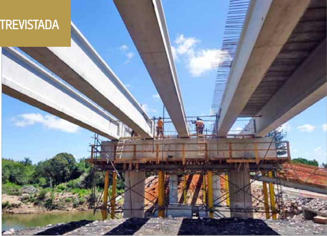
Ponte sobre o Arroio Passo do Pinto – Ecosul – implantação de nova obra
