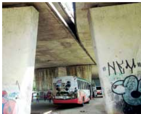
Figura 9 – Detalhe da vista inferior do mesmo trecho antes da execução do alargamento
