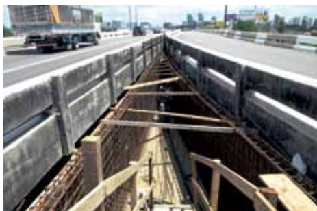
Figura 8 – Detalhe da execução da estrutura no trecho final do alargamento, ligando o novo tabuleiro a duas alças
