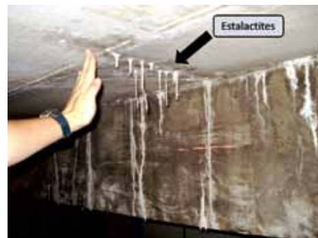
Figura 2 – Eflorescências geradas pelo tratamento da água com NaCl, que agredem o aço das armaduras
