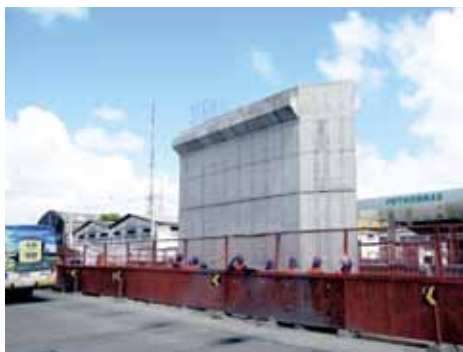
Figura 11 – Pilar P4 após a execução no canteiro central da avenida
