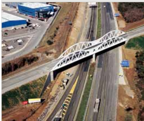
Figura 19 – Vista general del viaducto de Ruidellots terminado
