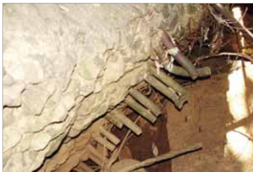
Detalhe das famosas barbas que Emilio Baumgart fez na construção, deixando 5 cm em cada um dos vergalhões
