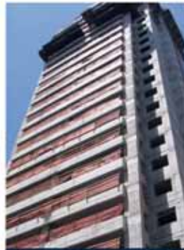
PAREDE DE CONCRETO
