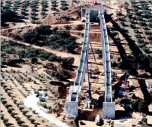
Figura 23 – Vista de las vigas prefabricadas instaladas en el viaducto de Quejigares
