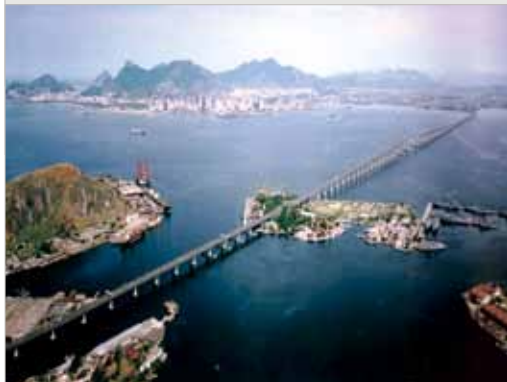
Foto 2 – Ponte Rio-Niterói. A maior obra de arte especial do hemisfério sul, com 14 km
