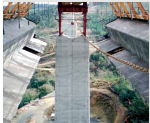
Figura 21 – Cimbra autilanzable abierta para el lanzamiento durante la construcción del viaducto del Sar
