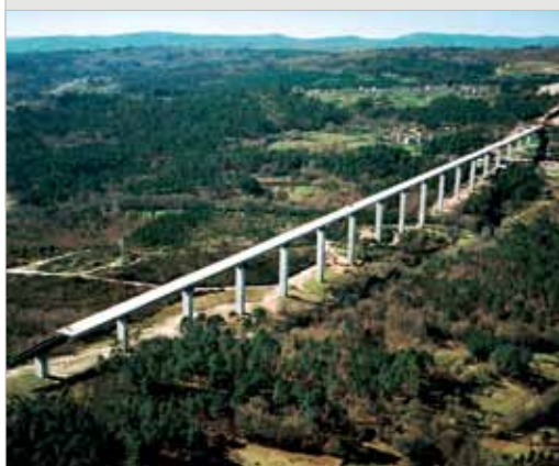
Figura 14 – Vista general del viaducto de Arenteiro
