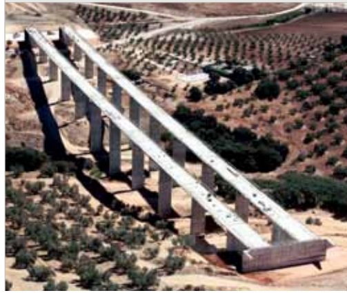
Figura 24 – Vista de viaducto de Quejigares terminado
