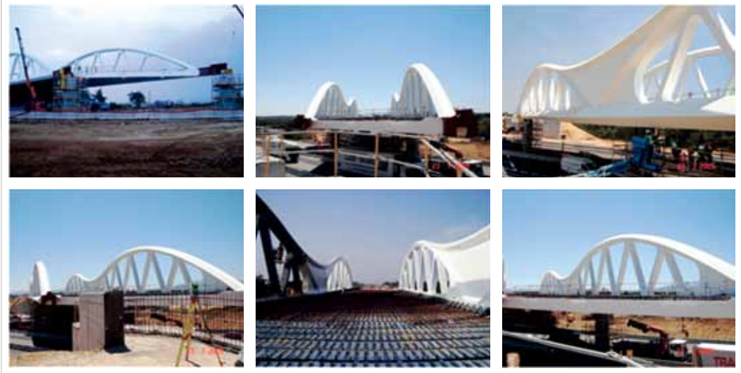
Figura 18 – Distintos estados de la construcción y empuje del viaducto de Ruidellots
