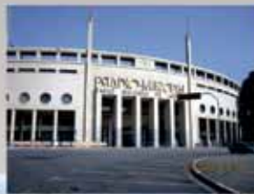
recuperação e reforço de edificações
