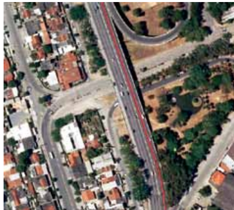
Figura 1 – Vista aérea do viaduto Capitão Temudo
