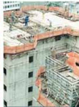
PAREDES DE CONCRETO
