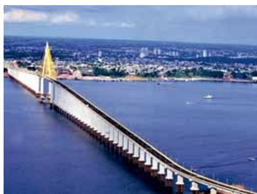
Figura 1 – Fotografias da Ponte sobre o Rio Negro
