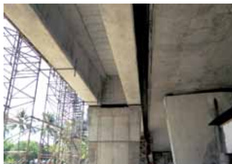
Figura 13 – Vista do tabuleiro após o alargamento
