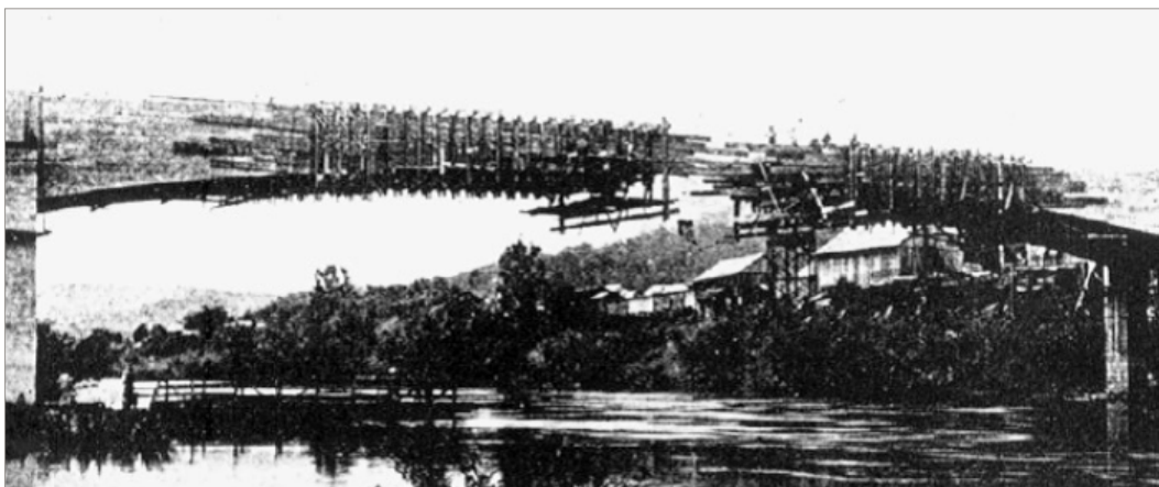
Fase da construção onde as partes da Ponte Emilio Baumgart são unidas em seu meio
