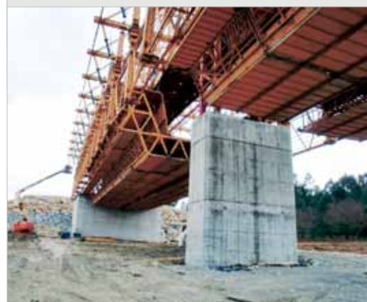
Figura 22 – Cimbra autolanzable cerrada antes del inicio de la construcción de un vano durante la construcción del viaducto del Sar
