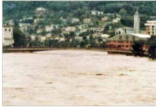
Enchente de Julho de 1983, onde, ao fundo, se observam os dois prédios que foram “corresponsáveis” pela queda da Ponte Emílio Baumgart
