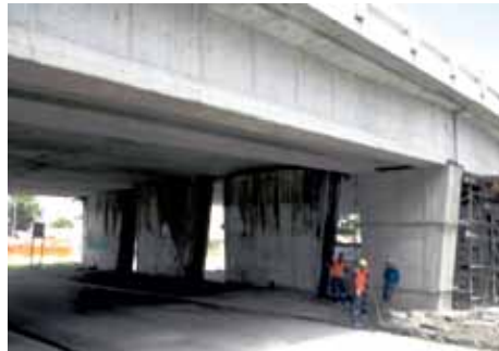
Figura 12 – Vista lateral do alargamento do tabuleiro celular com a utilização de vigas pré-moldadas
