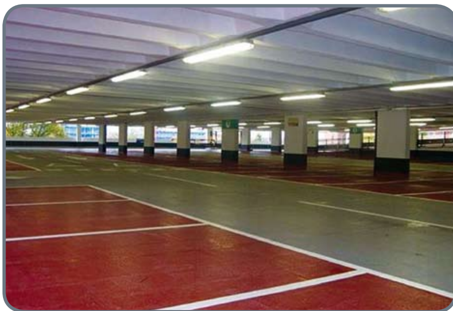
Piso de estacionamento: além da resistência, outros fatores de projeto, como a planicidade, devem ser considerados
