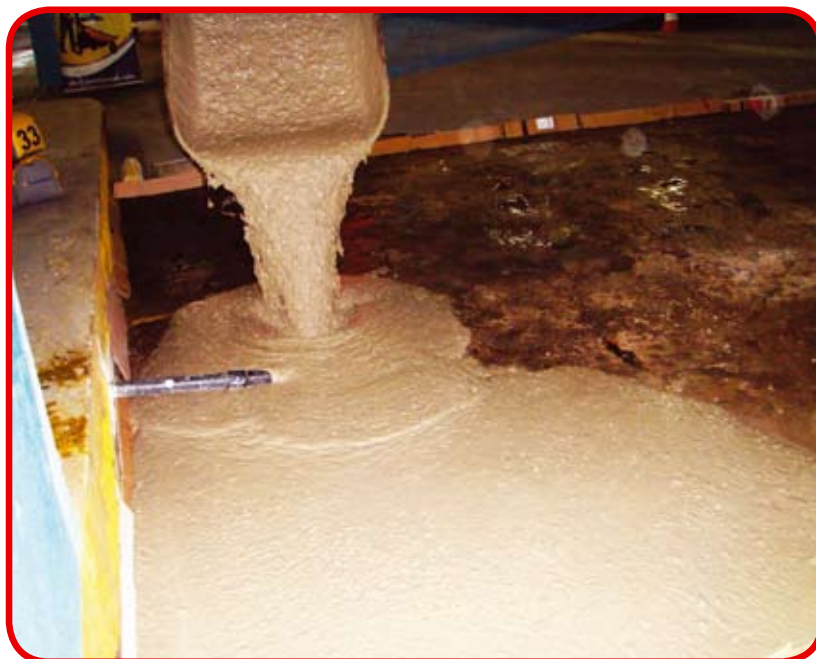
Execução do piso
