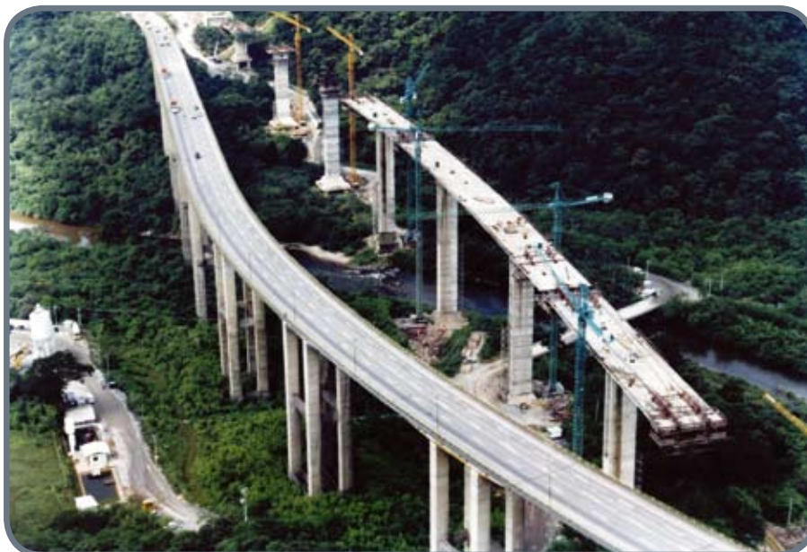
Foto aérea da Pista dos Imigrantes – resistência para suportar o próprio peso e das cargas móveis
