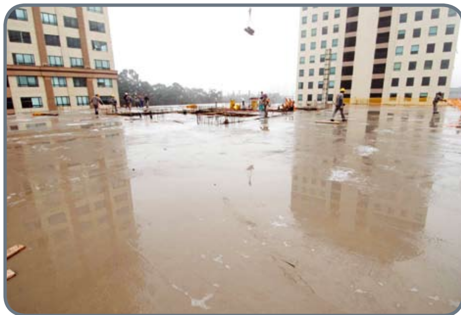
Laje de concreto curada
