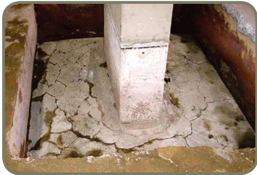
Fundação de edifício comercial em Recife
