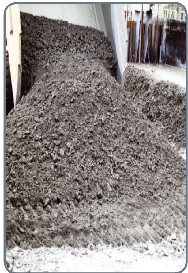
As fases de agregado e pasta do concreto compactado com rolo
