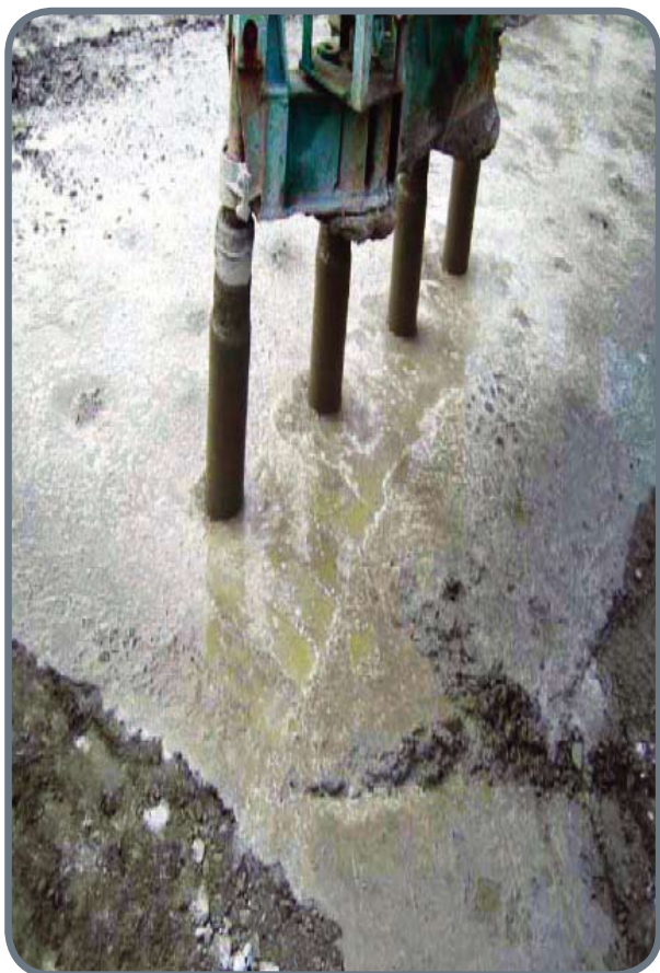
Adensamento do concreto lançado
