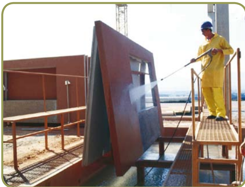
Concreto lavado (agregado exposto) em painel arquitetônico
