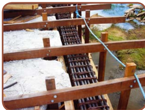
Detalhe do reforço de armadura da viga de reforço
