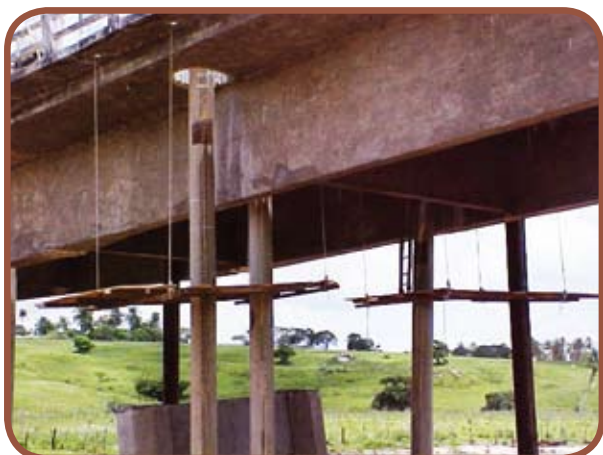
Detalhe do escoramento da ponte
