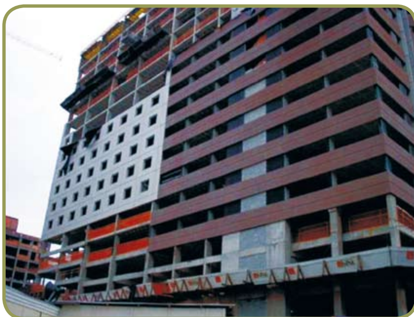
Concreto lavado (agregado exposto) em painel arquitetônico
