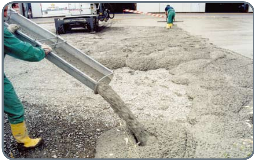
Concretagem do piso de Aeroporto em Bologna
