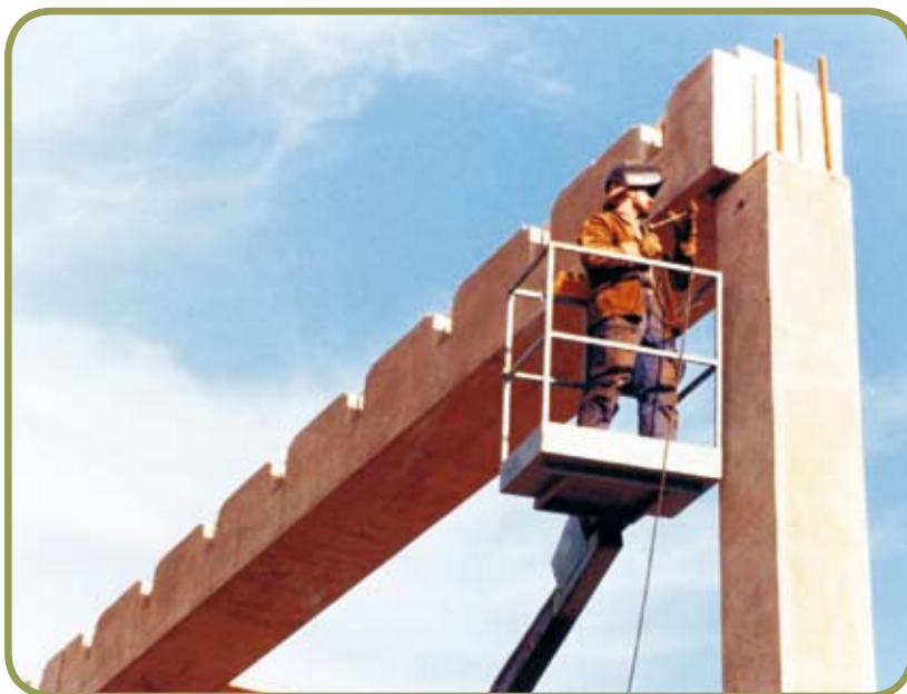
Execução de ligação soldada na Inglaterra [foto cedida por Kim Elliott]
