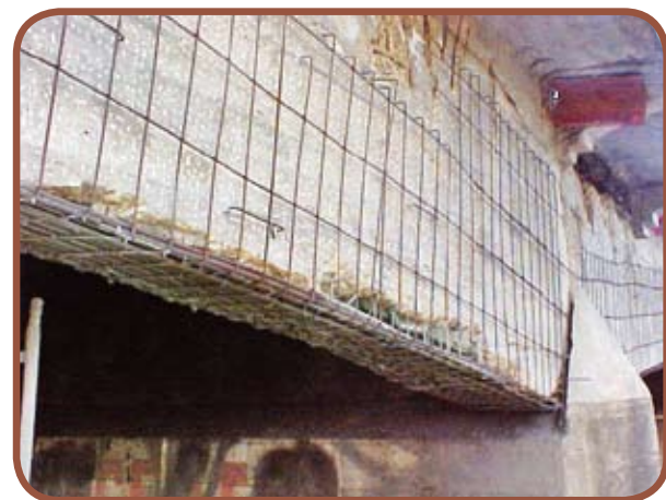
Reforço com armaduras nas vigas
