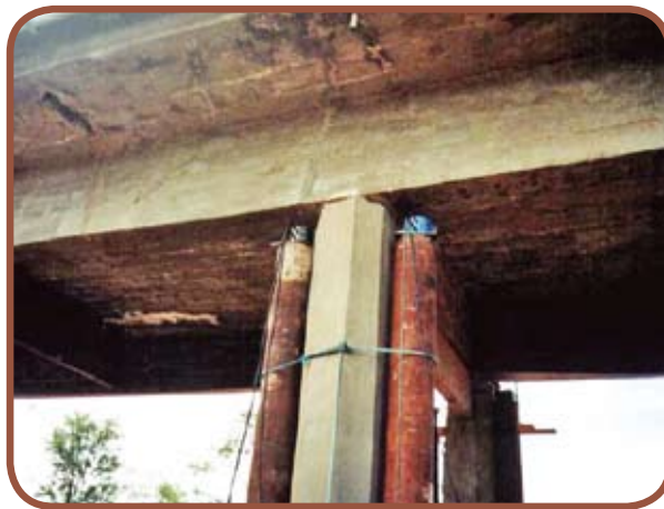
Vista dos macacos hidráulicos durante a operação de macaqueamento da Ponte Dois Irmãos
