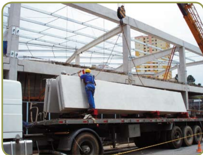
Transporte e montagem de painel de fachada
