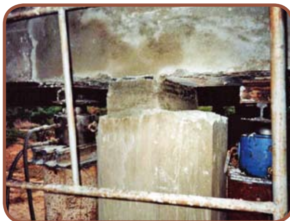
Macaqueamento da ponte com introdução de aparelho de apoio
