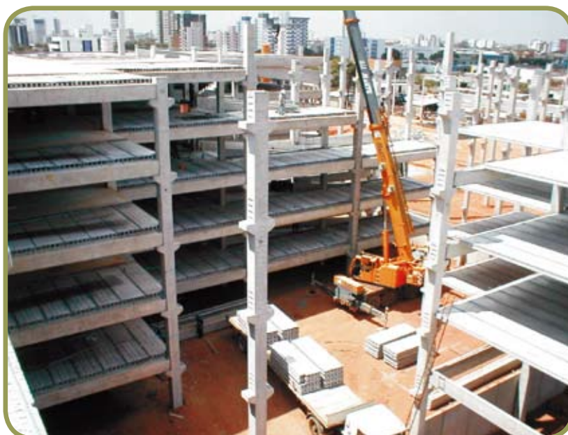
Montagem de edifício de múltiplos pavimentos
