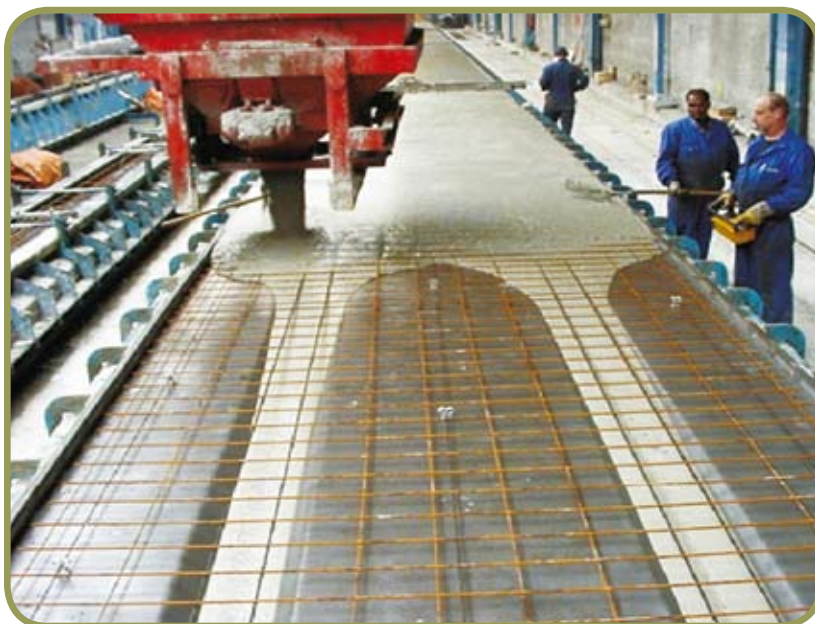
Aplicação de concreto auto-adensável em painel pré-fabricado na Europa [foto cedida por Kim Elliott]
