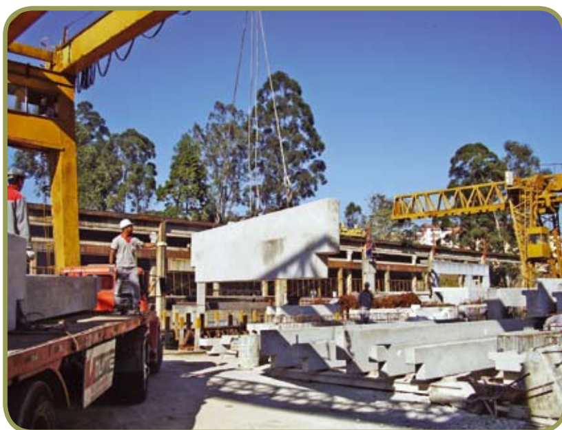
Armazenagem e transporte de peças pré-fabricadas
