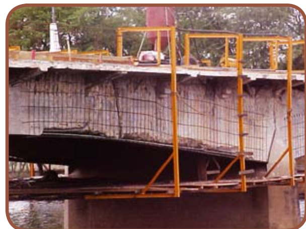
Detalhe das plataformas suspensas
