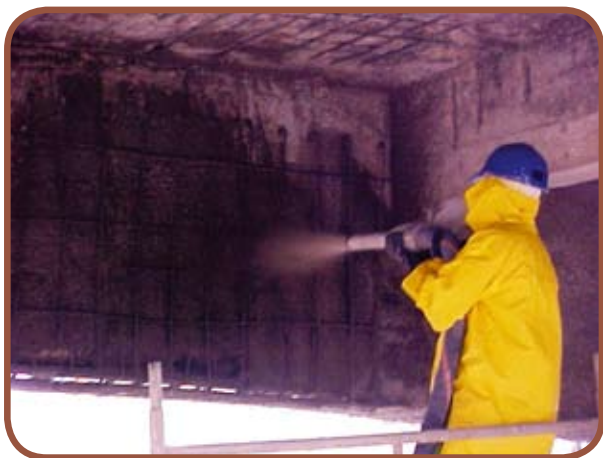
Aplicação de concreto projetado em viga
