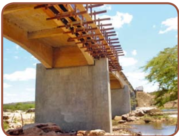
Vista do alargamento da Ponte Traíri
