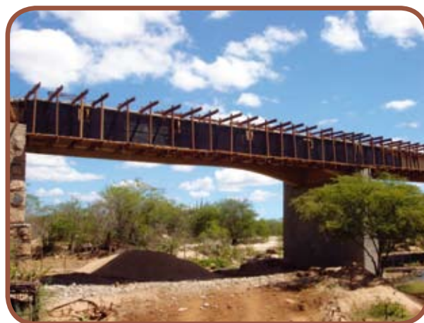
Vista do escoramento da viga de reforço ao longo da ponte
