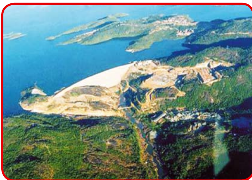
Foto 1 – Vista geral da UHE Serra da Mesa-GO, obra licitada com base nos documentos de Projeto Básico
