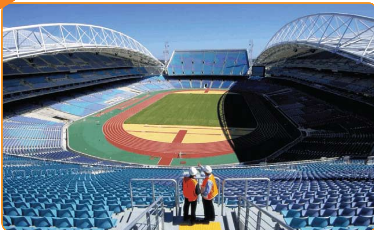
Figura 1: Estádio em concreto protendido, Sidnei, Austrália
