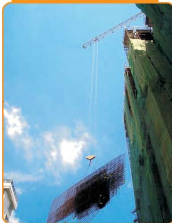
Figura 1 – Carga sendo transportada para a laje
