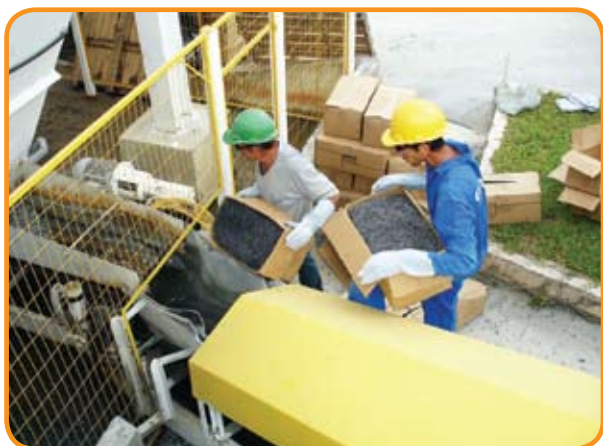
Figura 6 – Inserção das fibras na esteira da usina de concreto
