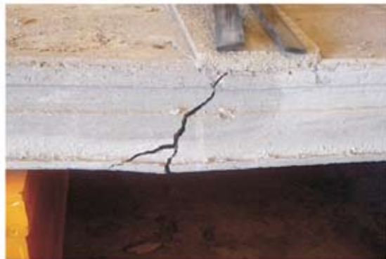
a – Fissuras em painéis sem capa
