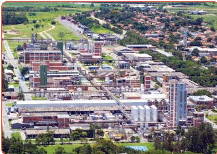
Vista aérea Complexo Químico Guaratinguetá
