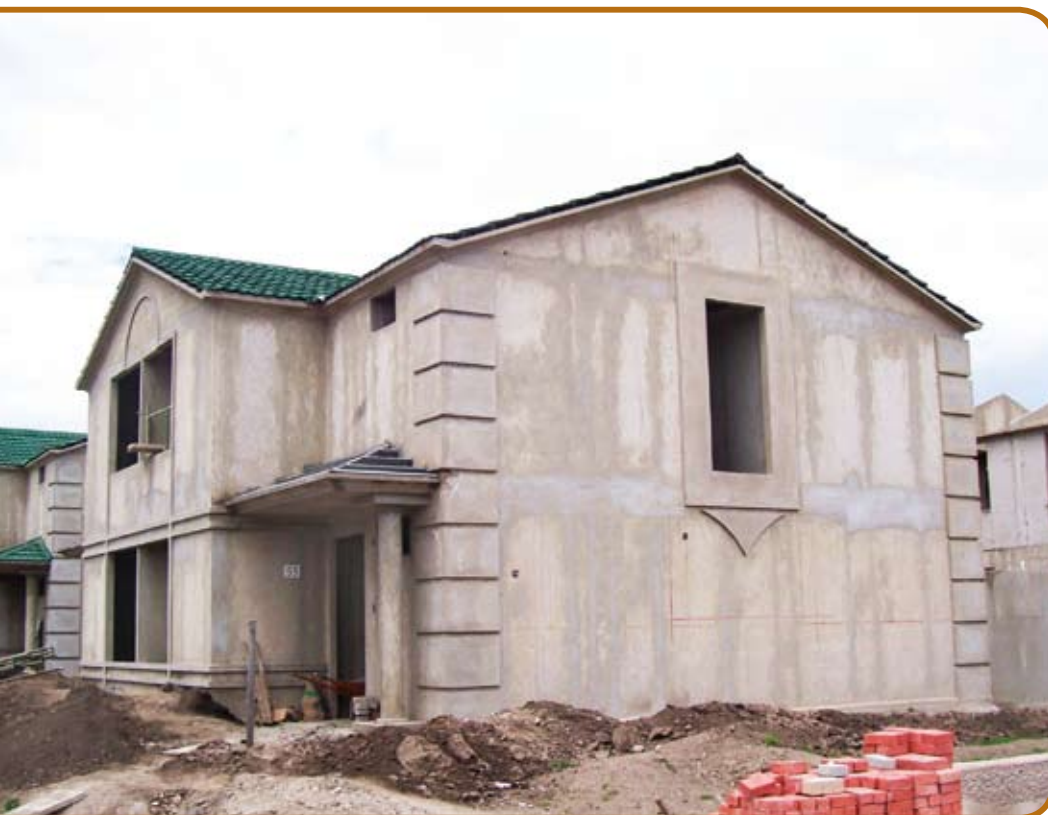
Figura 6: Sobrados sem acabamentos
