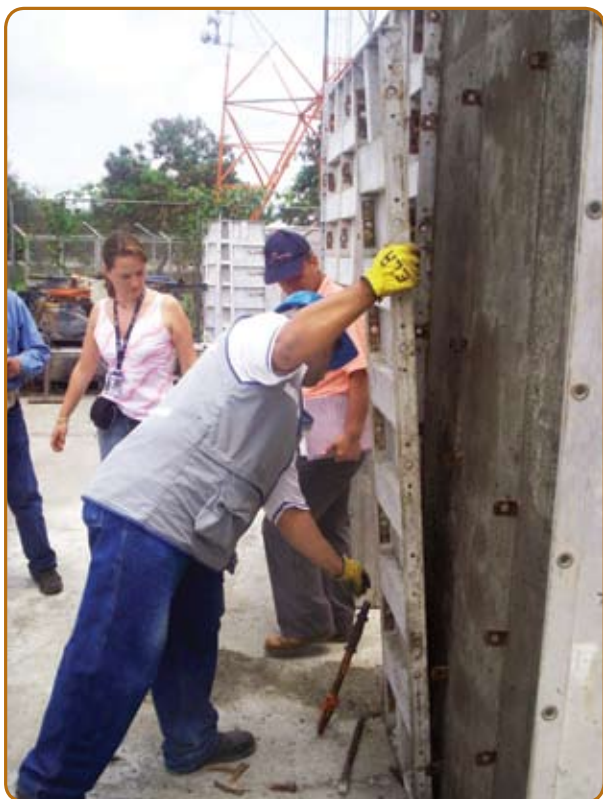
Figura 5: Desmoldagem
