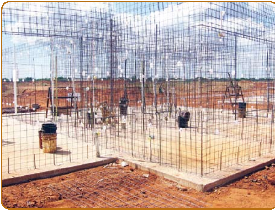
Figura 2: Montagem das Telas das Paredes
