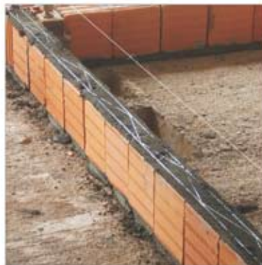
2ª Etapa: Colocação da treliça plana – MURFOR – sobre a argamassa de assentamento
