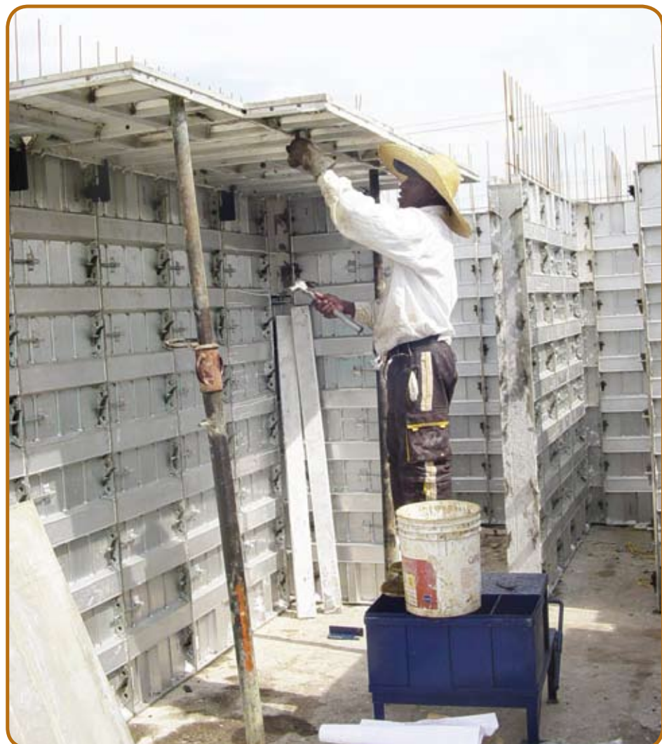
Figura 3: Montagem das Fôrmas da Laje
