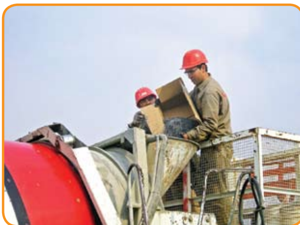
Figura 7 – Inserção das fibras diretamente no caminhão betoneira
