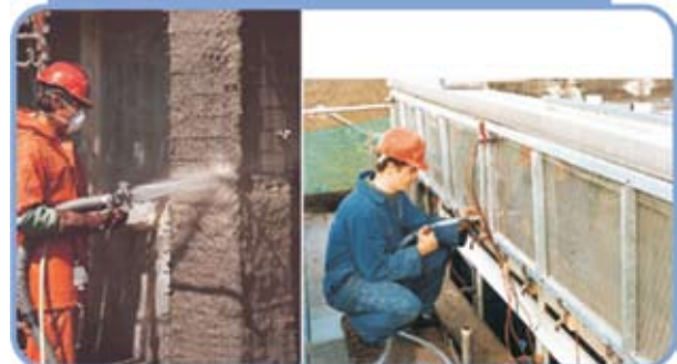
Figura 3 – Tipos de contatos eletroquímicos que podem ser realizados: utilizando poupa de celulose jateada ou utilizando tanques
