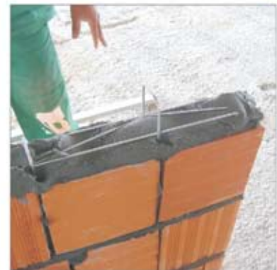
3ª Etapa: Assentamento das próximas fiadas de blocos
