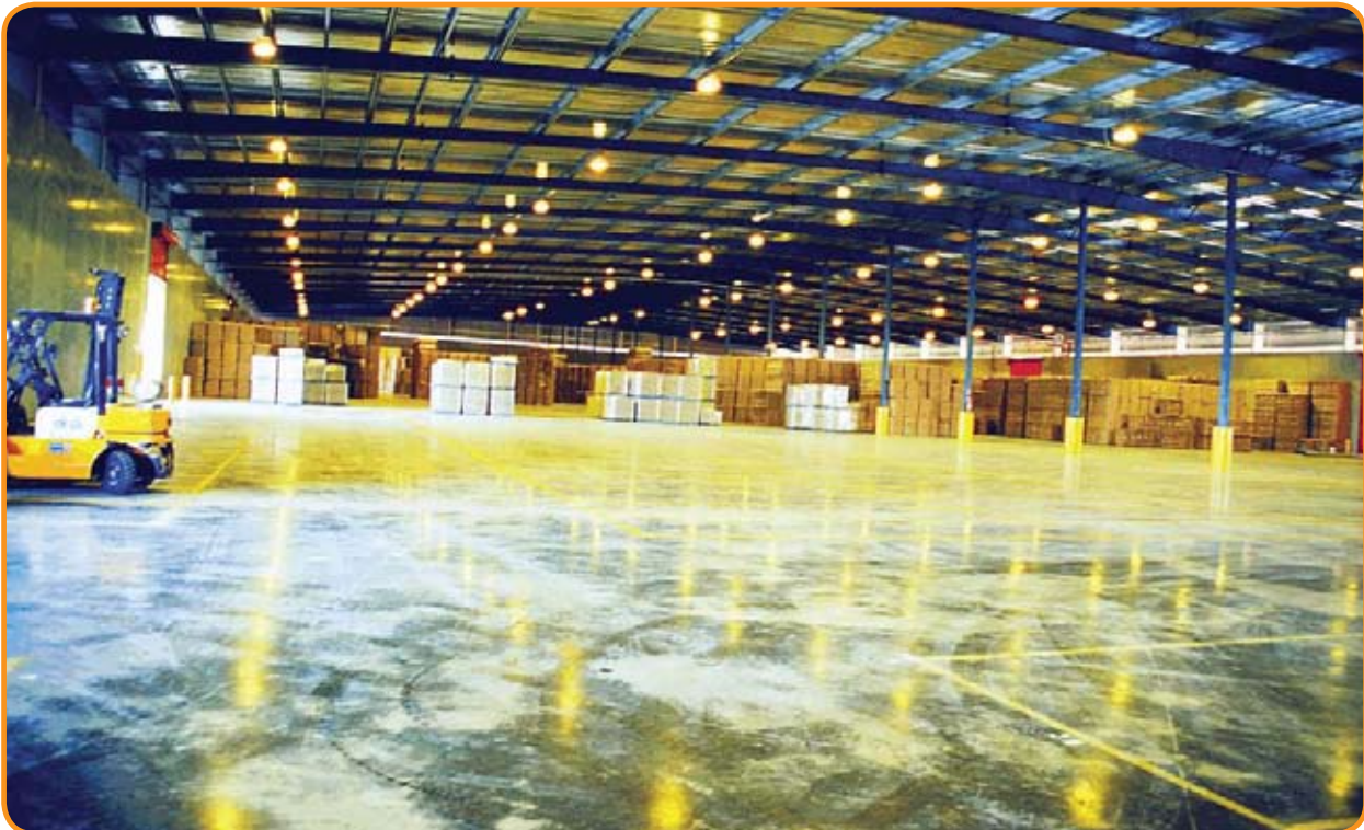
Figura 5: Piso protendido em Victoria, Austrália
