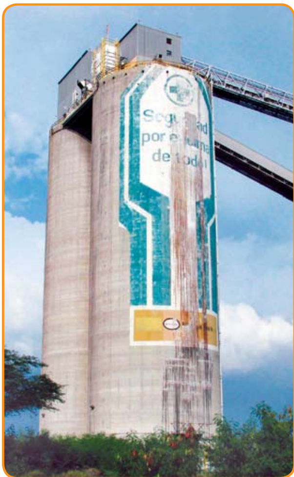
Figura 5: Vista geral da estrutura
