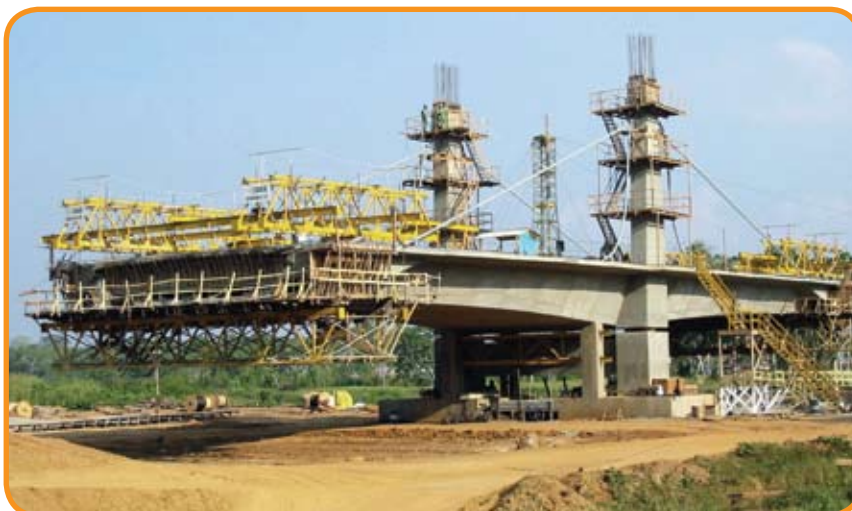
Figura 3 – Construção pelo método dos balanços sucessivos
