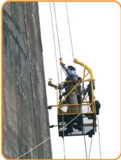
Figura 7 – Exame de percussão e ensaio de potencial elétrico
