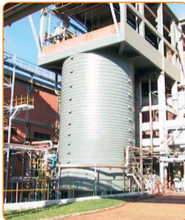
Figura 4: Tanque de uma fábrica de papel e celulose que foi reparado, protegido e reforçado com utilização de protensão externa
