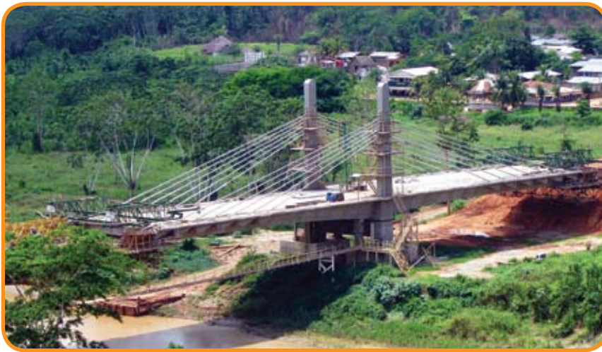
Figura 4 – Construção pelo método dos balanços sucessivos
