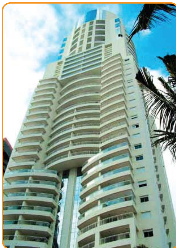
A imponência do Edifício Mandarin
